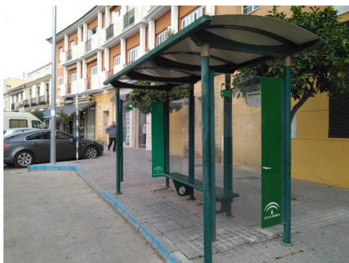
Av. Santa Ana (La Paz). Marquesina sin información de las líneas que operan y sin accesibilidad para PMR
