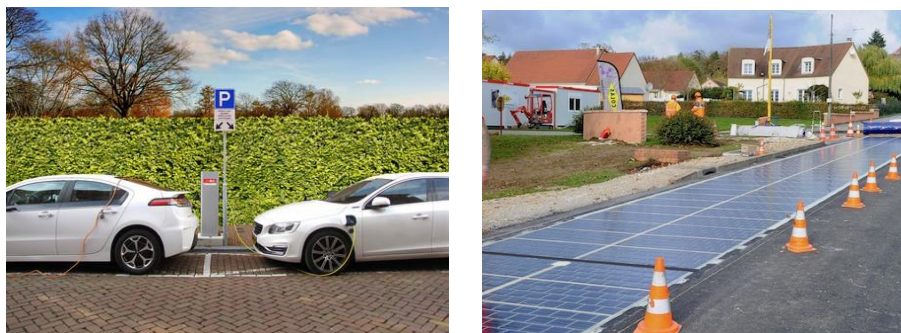
Ilustración 6: Calles inteligentes con integración de puntos de recarga para vehículos eléctricos
