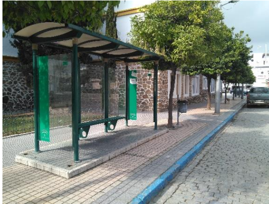
Ilustración 27: Parada de bus en Av. Pío XII. La tarima de la marquesina no permite el acceso a PMR
