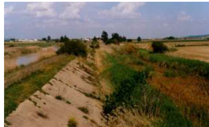
Desviación del curso del arroyo Fuentes por la construcción del Canal del Bajo Guadalquivir. En este tramo el arroyo circula paralelo al Canal
