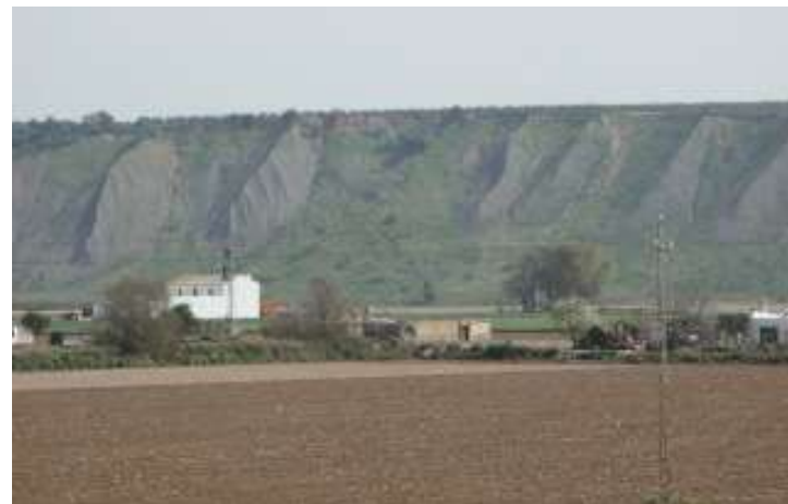
Escarpe de socavamiento lateral de cauce en margas del mioceno. Al pie del escarpe se sitúa un cauce abandonado por el Guadalquivir
