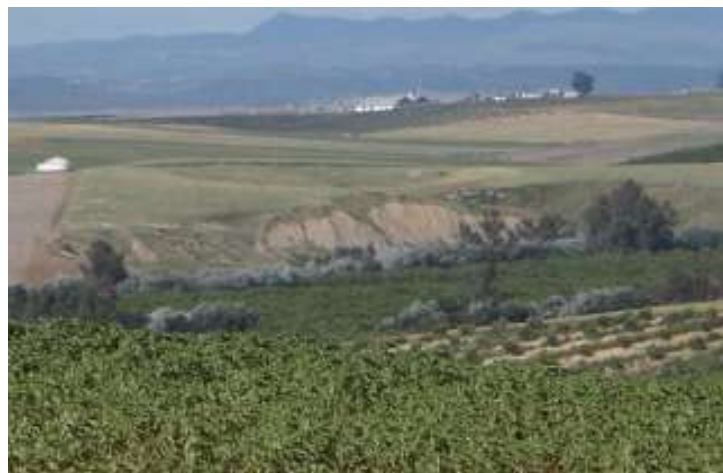
Gran escarpe de socavamiento lateral de cauce en el río Genil
