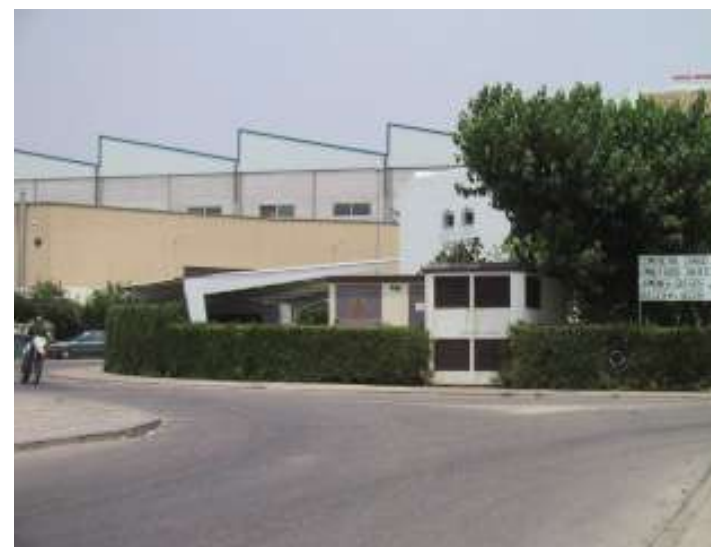
Centro de Transformación en Polígono Industrial
