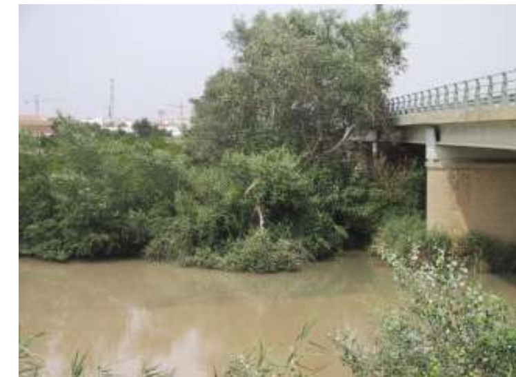
Punto de vertido colector al cauce Genil bajo puente acceso Sur
