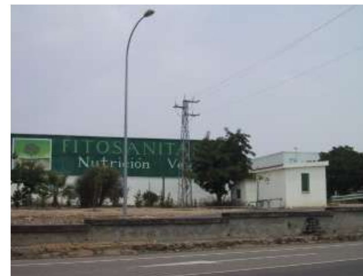
Tendido aéreo M.T. Palma-4 en Polígono Industrial
