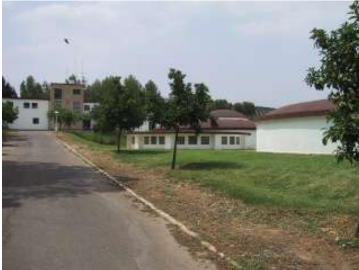
Estación Tratamiento de Agua Potable (E.T.A.P.)
