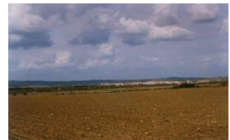
Sobreelevación de tierras generada por la construcción del Canal del Bajo Guadalquivir, situada sobre las terrazas bajas. Éste actúa como protección de las vegas situadas al sur del canal
