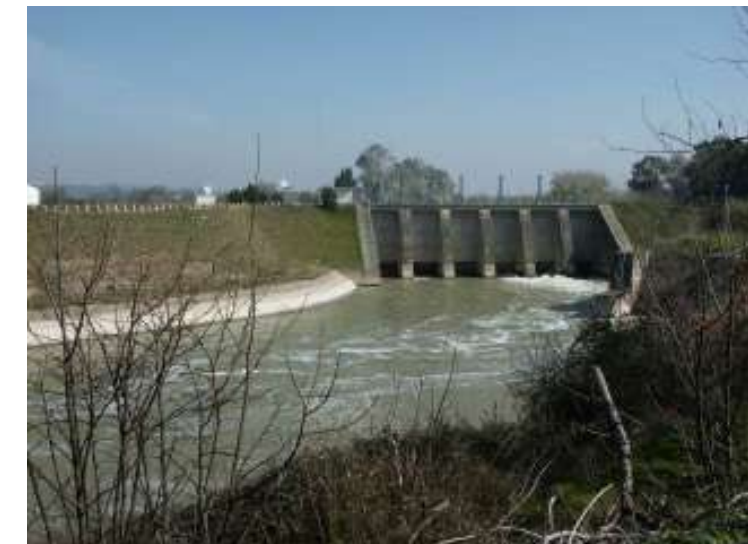
PRESA DE PEÑAFLO
